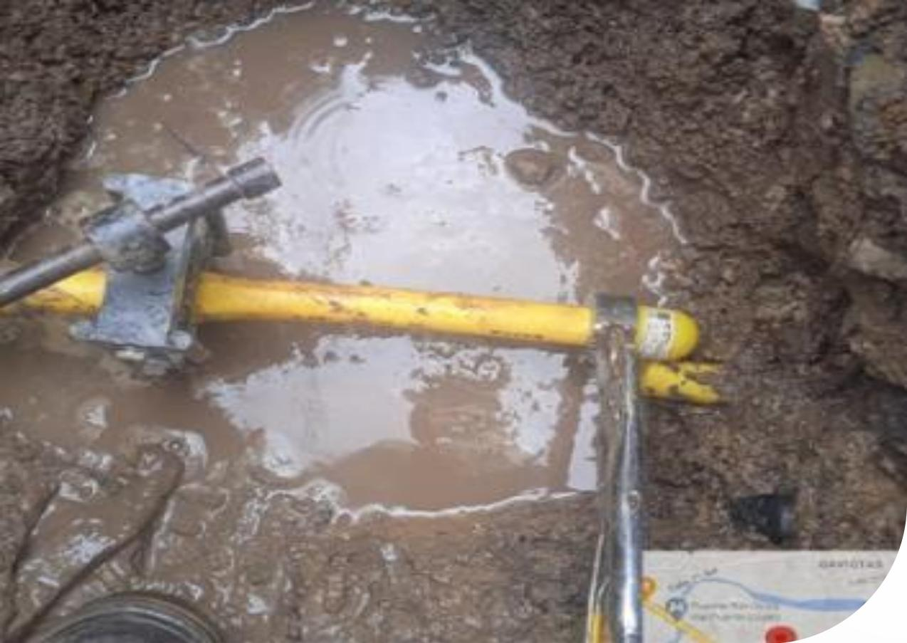
Una vez **identificada la conexión fraudulenta**, se procede a suspender la red de distribución de gas natural y suspende la conexión, eliminando así el riesgo para el sector.
